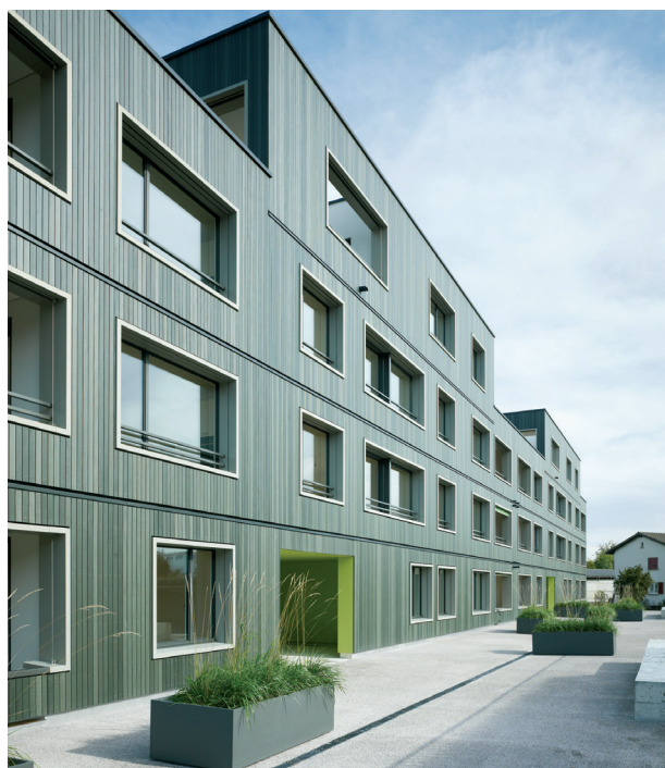
Nachhaltiges Mehrfamilienhaus aus Holz: Das swisswoodhouse in Nebikon.
